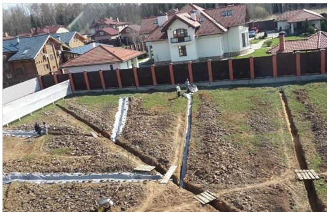
Рис. 2.4.1. Строительство закрытой дренажной системы
