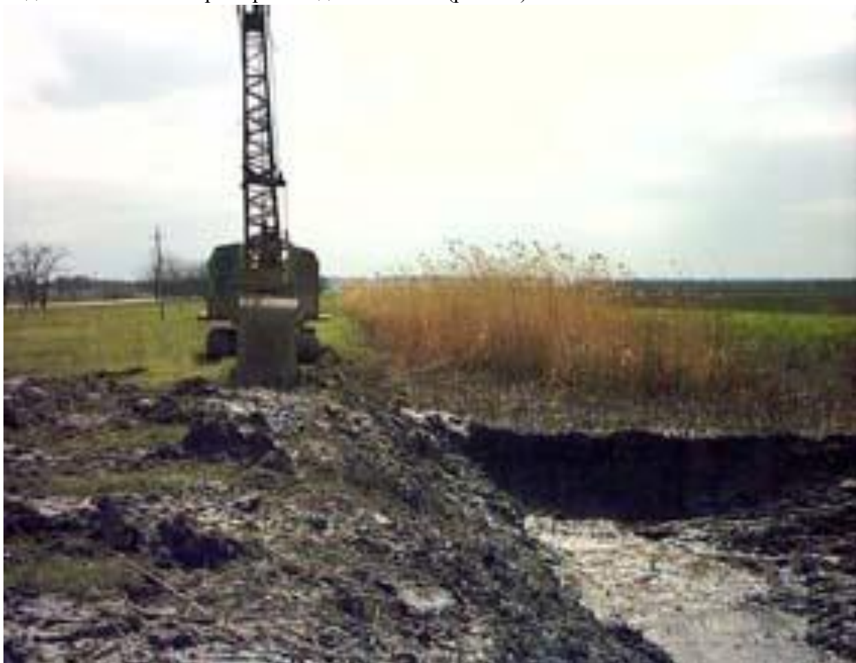
Рис. 15. Очистка сбросного канала от заиления
