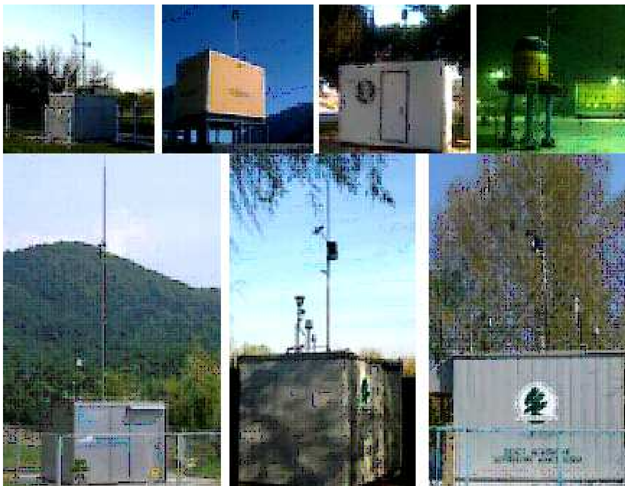
Рис. 126. Автоматические станции контроля атмосферного воздуха
